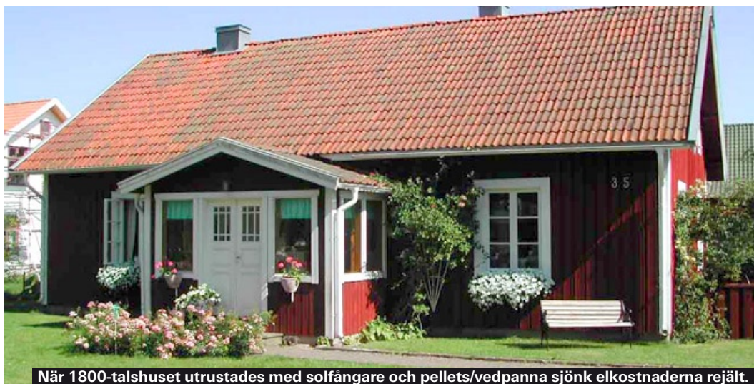
När 1800-talshuset utrustades med solfångare och pellets/vedpanna sjönk elkostnaderna rejält.
